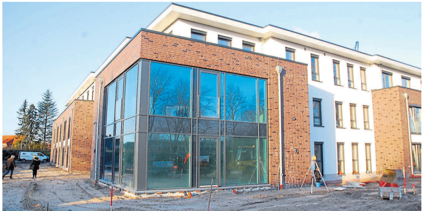
Ein Jahr nach Beginn der Tiefbauarbeiten ist das erste der beiden Gebäude des „Wohnpark Schortens“ von Pflegetbutler an der Beethovenstraße schon weit gediehen. Aktuell läuft der Innenausbau, im Mai kommen die Möbelwagen. BILDER: OLIVER BRAUN
