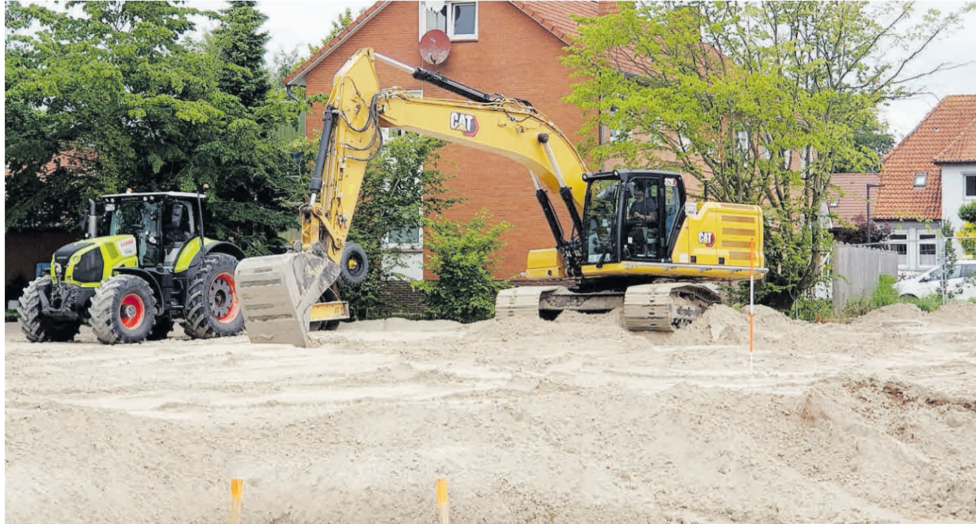
Bauarbeiten in der zweiten Reihe an der Straße Osterende: Hier entstehen Senioren-Apartments.
