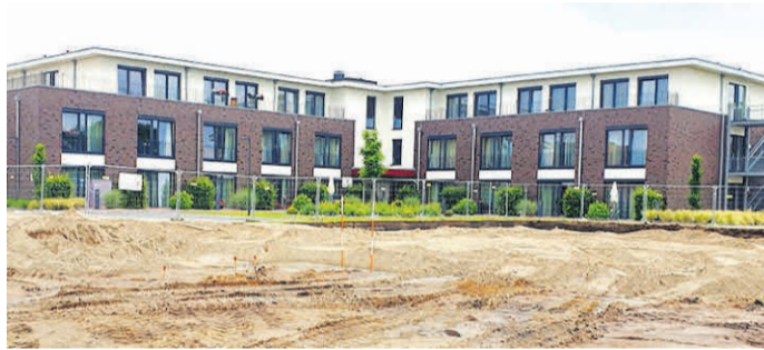
Blick über den neuen Bauteppich auf den Wohnpark: Spiegelverkehrt wird hier demnächst das neue, baugleiche Gebäude entstehen.
