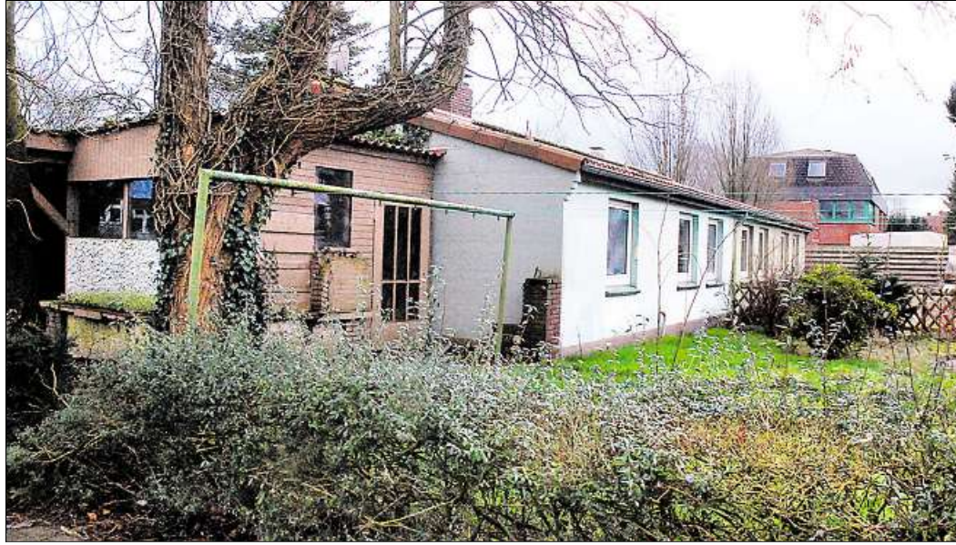
Die alten Obdachlosenbaracken an der Beethovenstraße (im Hintergrund das frühere GMA-Verwaltungsgebäude, heute Energiesparhaus Meinecke) werden abgerissen. BILDER: OLIVER BRAUN
