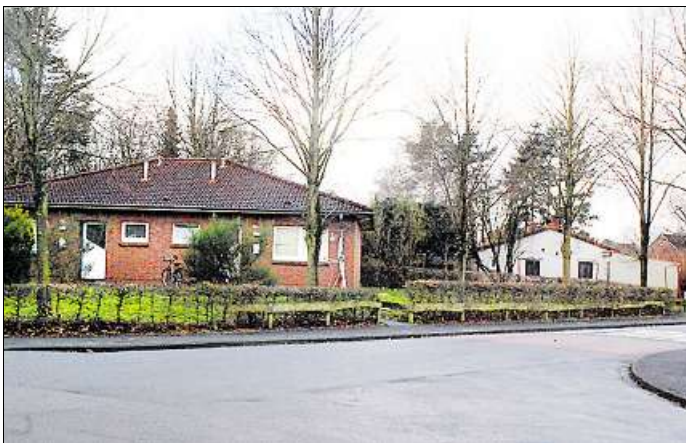
Diese neueren städtischen Wohnungen an der Ecke Beethovenstraße/Am Fort stehen derzeit nicht zur Disposition.
