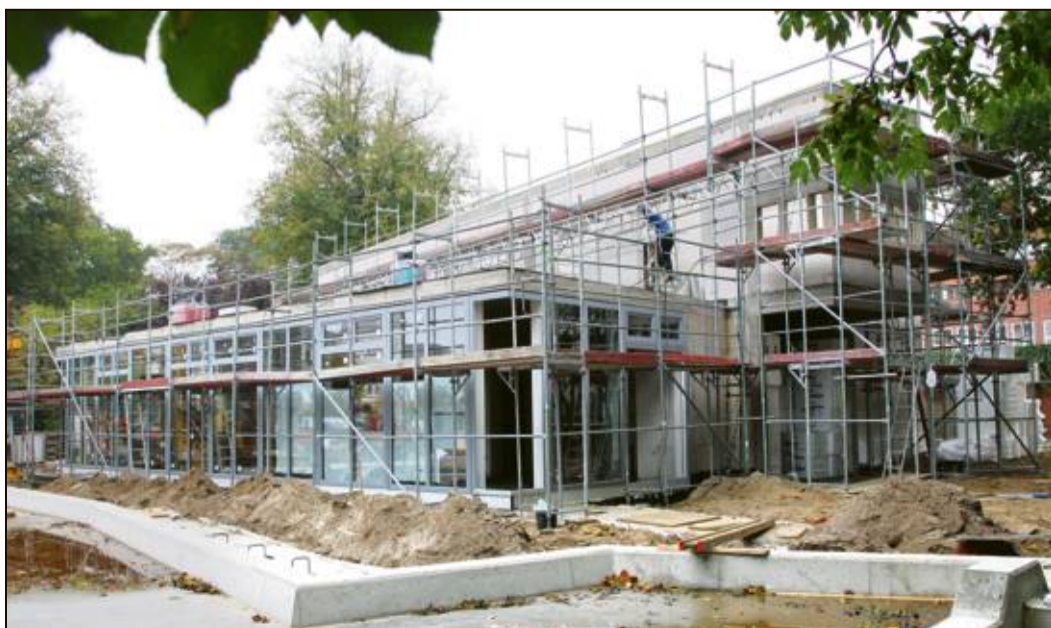
Der Neubau des Johann-Ahlers-Hauses in Jevers Innenstadt schreitet voran. Bis Ende des Jahres soll es fertiggestellt sein. WZ-FOTO: LÜBBE
