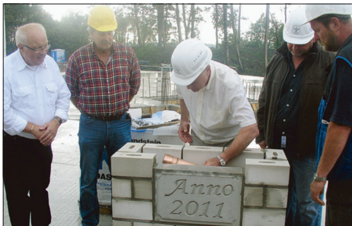
Grundsteinlegung: Bürgermeister Wolfgang Schneider und Architekt Werner Geiken schauen Bauherr Peter Janssen zu. Daneben der Geschäftsführer der Janssen Gruppe, Heiko Friedrich, und Bauleiter Klaus Kruse. EZ-Bild: Saathoff
